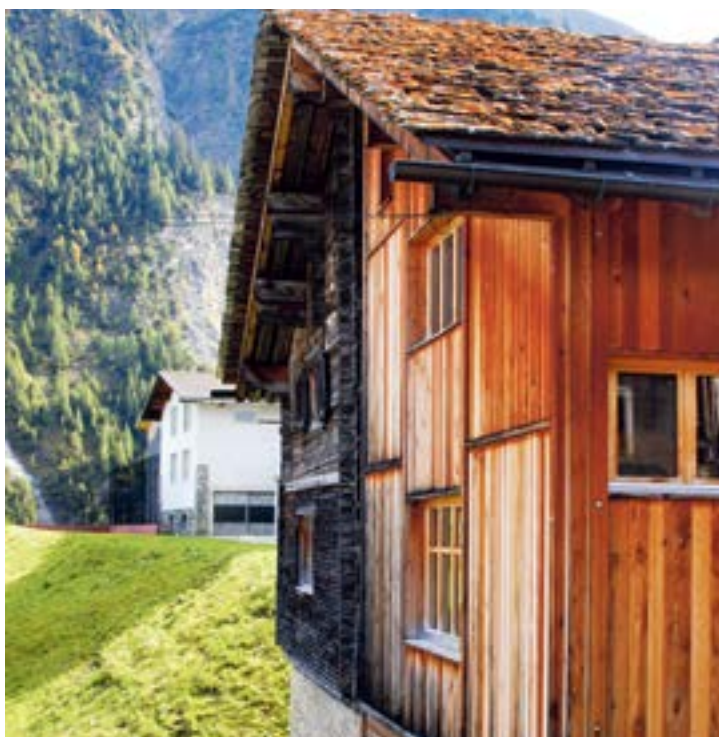
Gute Sanierung alter Holzbauten mit neuer Haushälfte.
